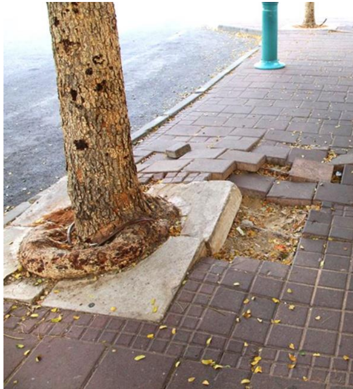
איור 23 - עץ רחוב עם בית גידול מוגבל Figure 23 - Limited Street Tree pit
