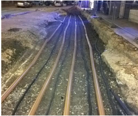
איור 30 - תעלת נטיעה המשכית עם אדמת מבנה Cu Soil, רח' תובל רמת גן 2016 Figure 30 - CU Soil Continuous Planting Trench - Ramat Gan
