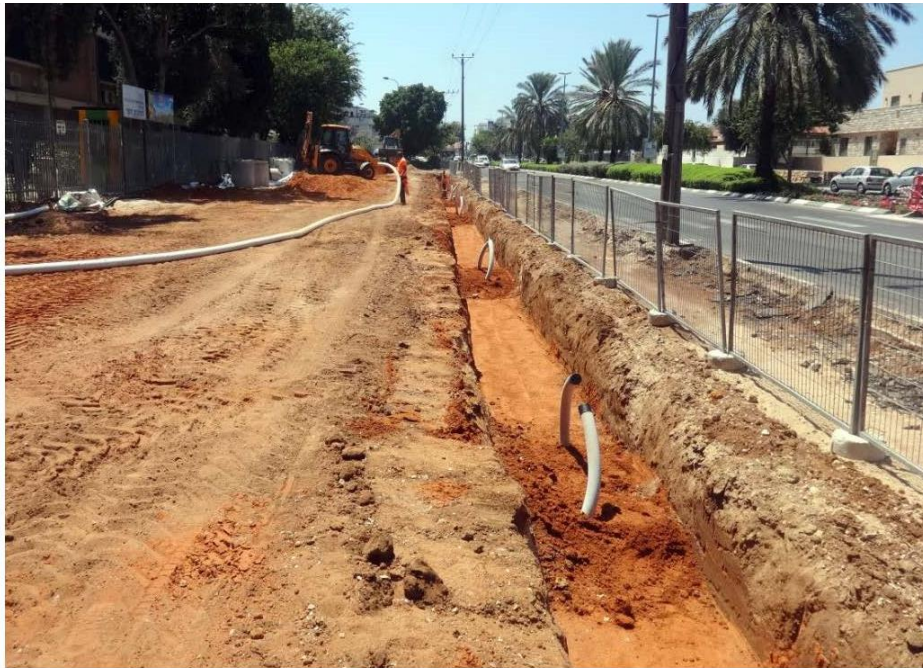
איור 22 - תעלת נטיעה המשכית Soil Trench במילוי אדמת מבנה מבוססת חול פיילוט תעלת נטיעה המשכית, רחוב ההגנה, תל אביב.
