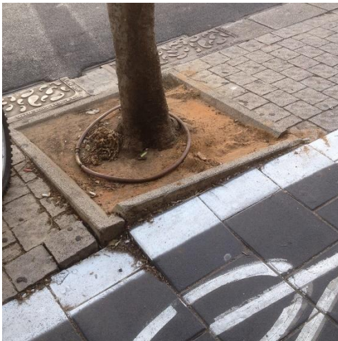
איור 28 - תעלת נטיעה המשכית ברחוב אבן גבירול, תל אביב, עץ רחוב ממין מיש בונגה, 7 שנים לאחר נטיעה מוריה סקלי אדריכלות נוף
